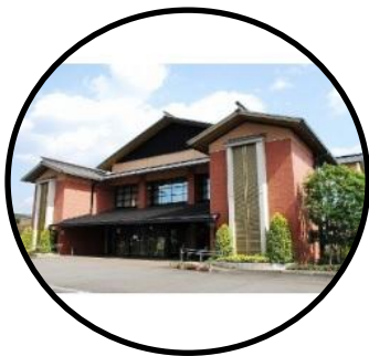
花咲きホール外観
